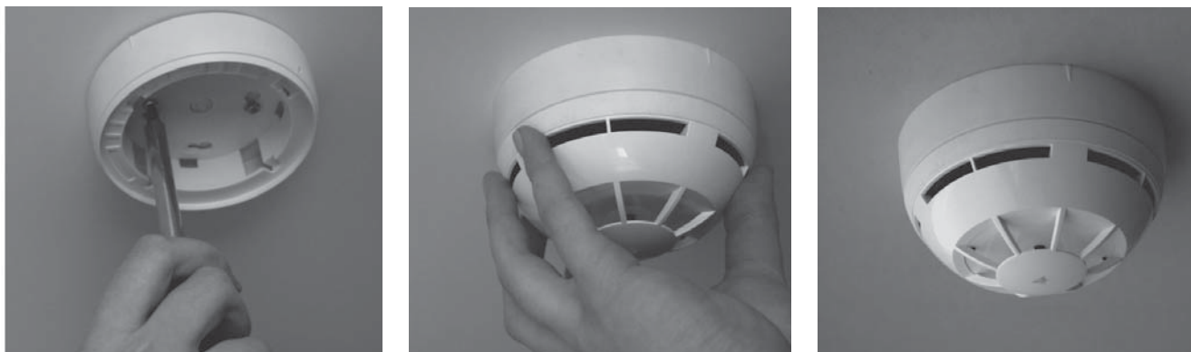
Рис. 2 Установка одного радиоканального адресно-аналогового пожарного извещателя «Аврора-Р» занимает не более минуты
